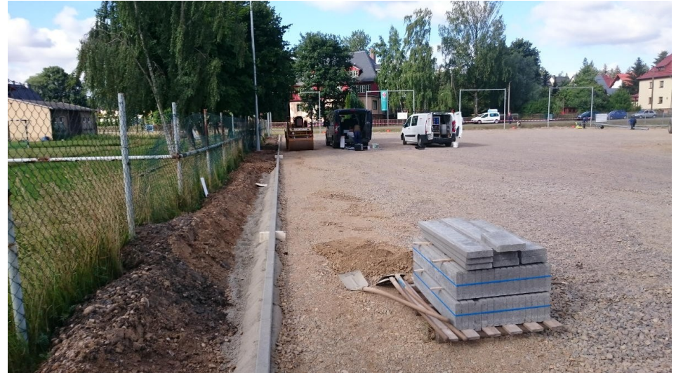
Abbildung 1: fertiggestellte Schottertragschicht und Einbau der neuen Flutlichtanlage am Kleinfeld
