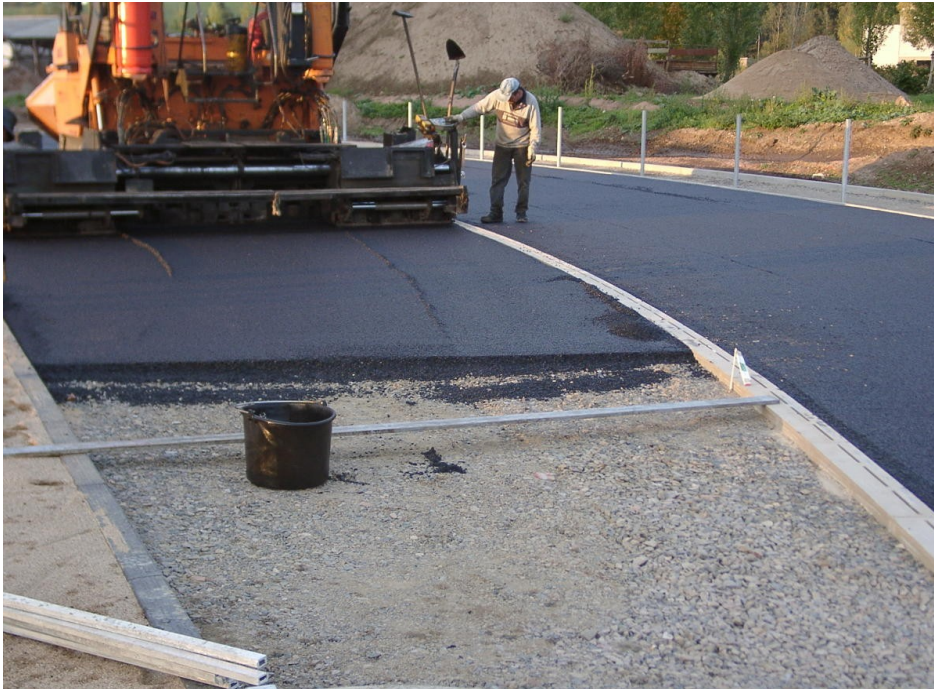
Einbau Dränasphalt in Laufbahnbereichen
