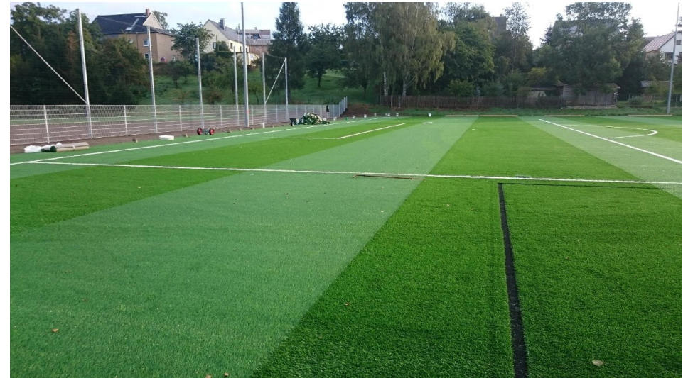
der neue Kunstrasen wird verlegt
