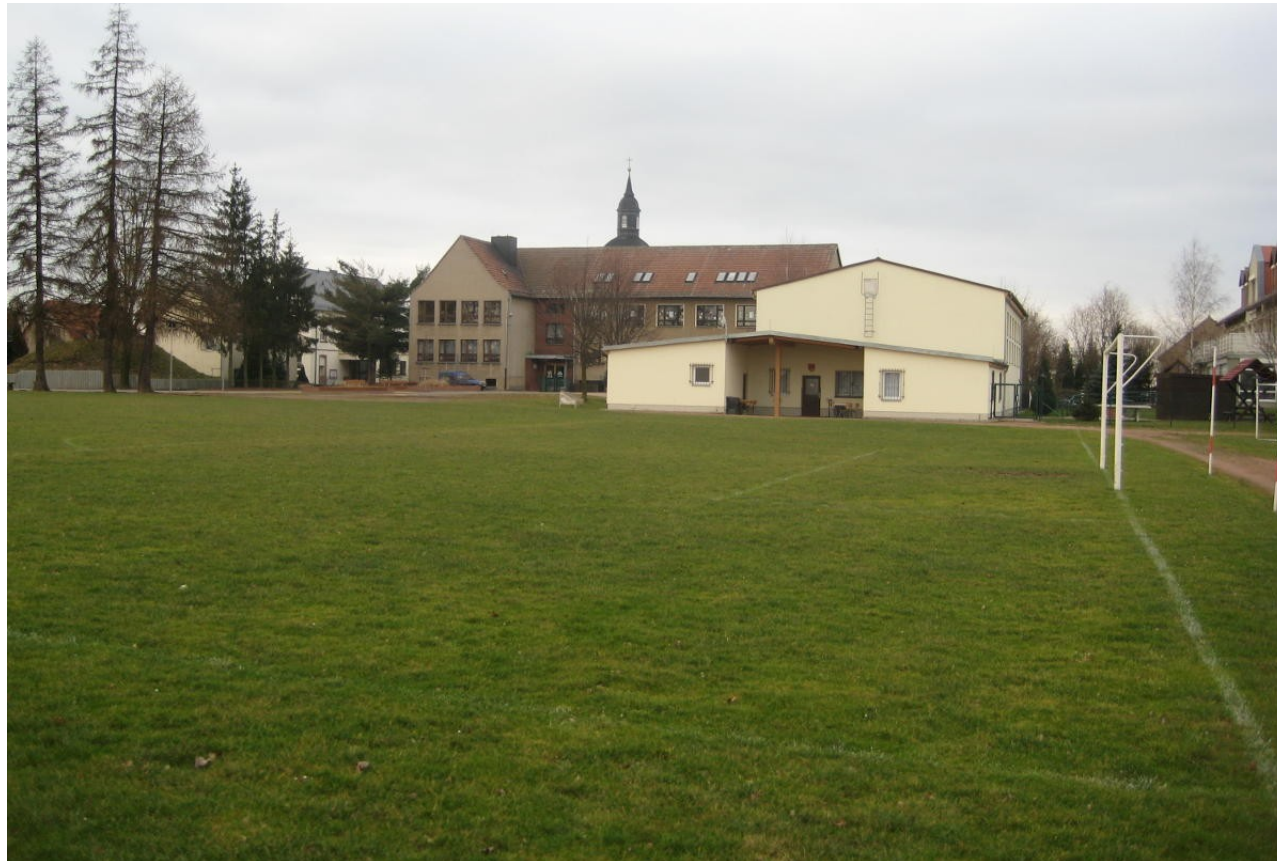
zu sanierendes Großfeld in Naturrasen
