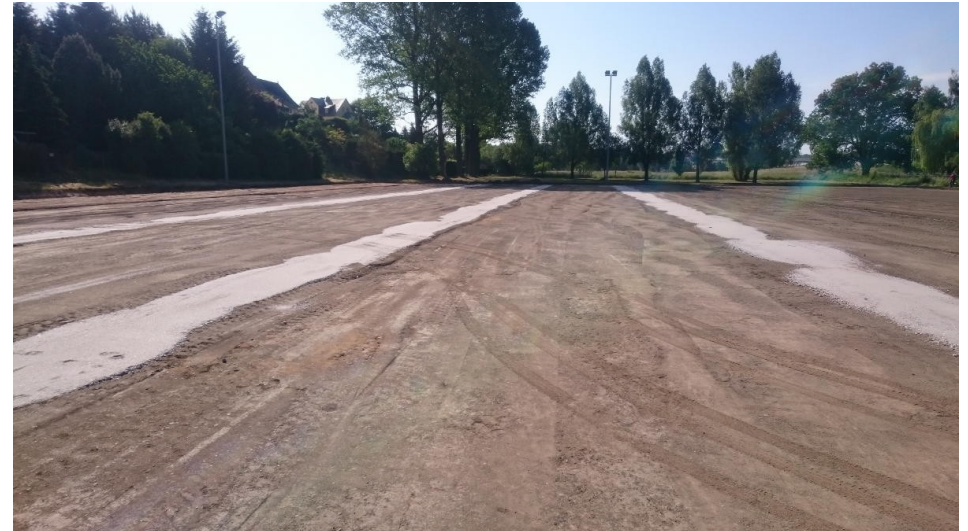
neue Dränageleitungen eingebaut, Planum hergestellt
