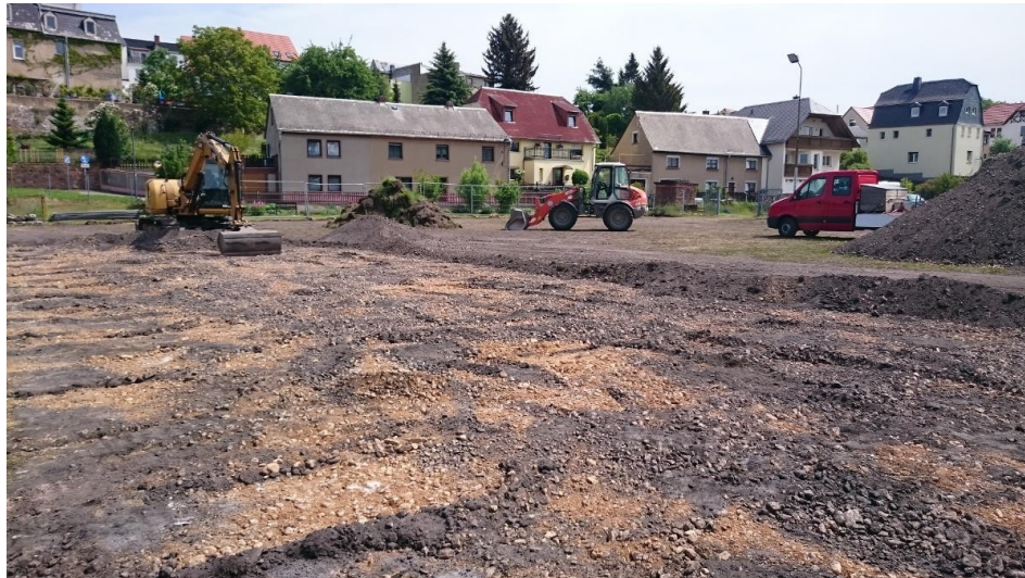
Ausbau der alten Tragschichten (belastetes Material) auf dem Kleinfeld im Stadion
