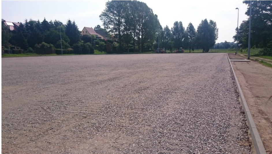
Schottertragschicht hergestellt
