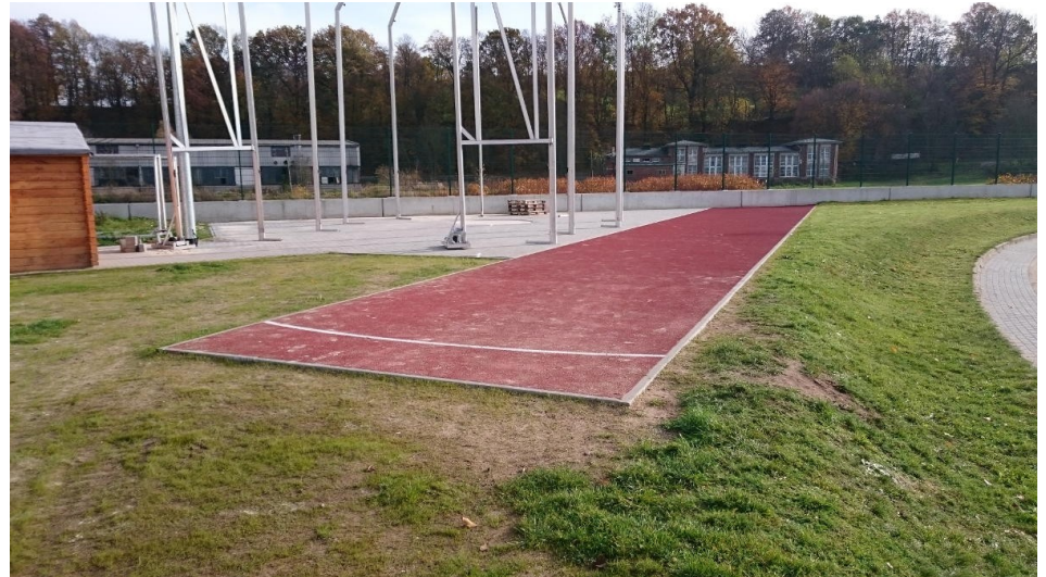
neue Anlaufbahn der Werferanlage
