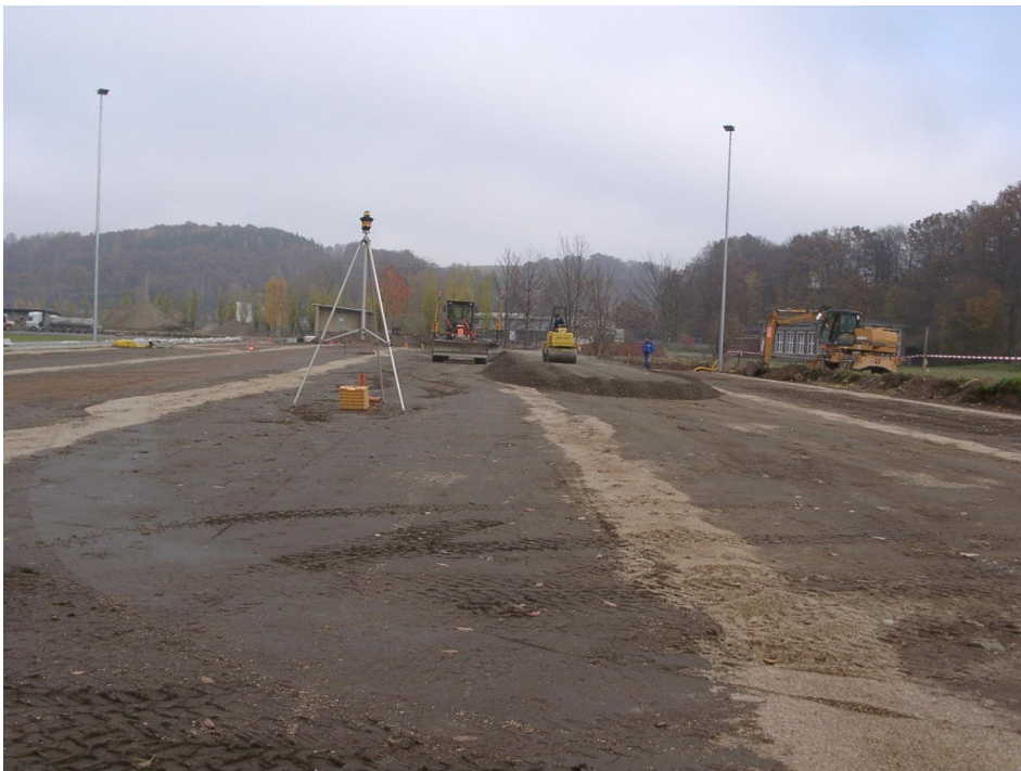
Einbau Schottertragschicht auf dem Kleinfeld
