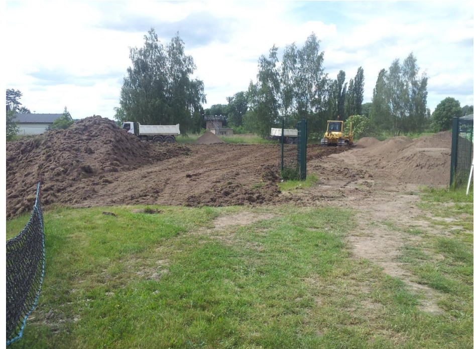
Herstellung Grobplanum für neue Werferanlage
