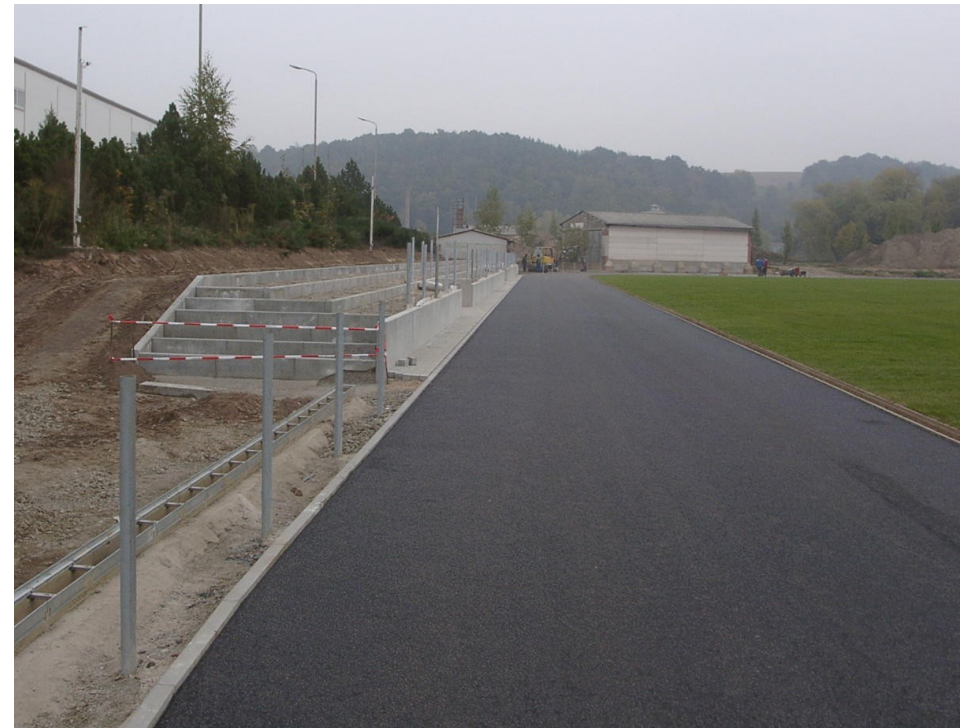
neue Tribüne grundhaft fertiggestellt
