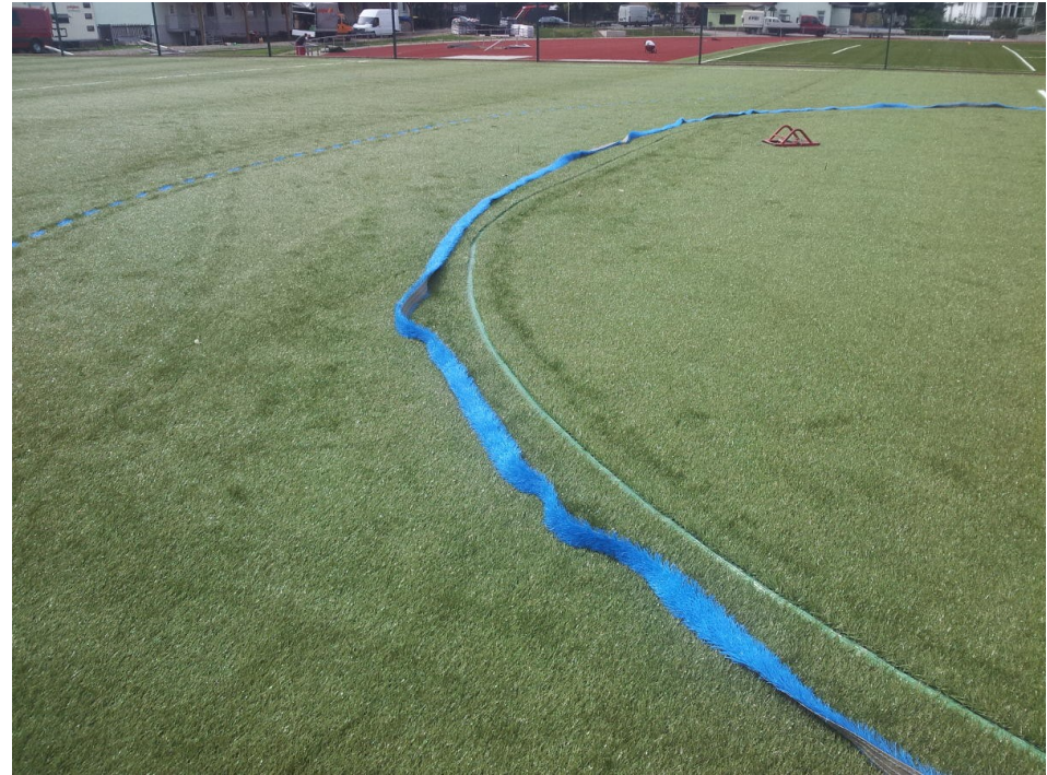
Einlegen der Linierung auf dem Kleinfeld
