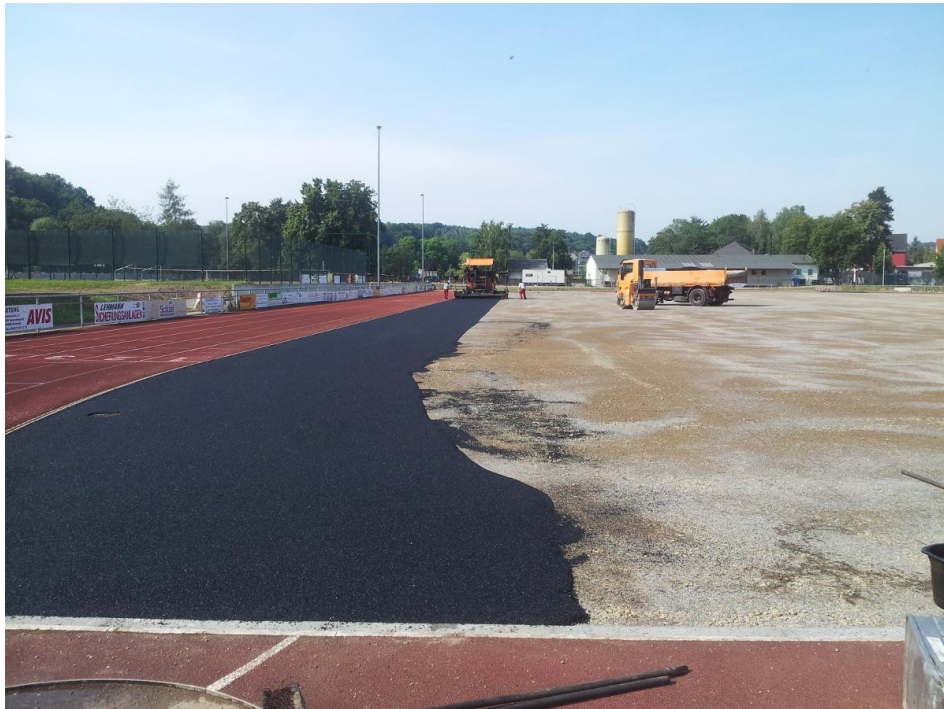
Einbau Elastikschicht auf dem Großfeld
