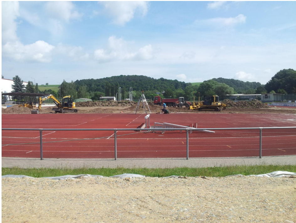
Abtrag Grasnarbe auf Naturrasenfeld, Vorbereitung Umbau zu Kunstrasen
